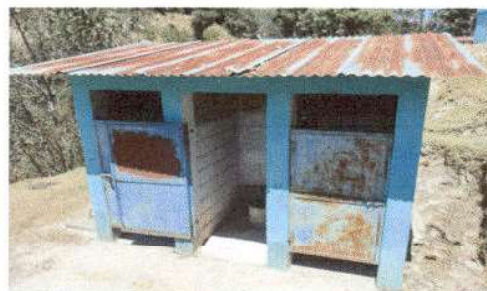
Foto 3: Sustrucción sanitarios mas accesorios
