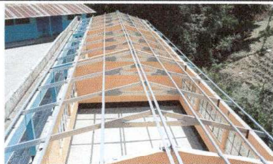
Foto 2: Sustrucción de estructura de madera por Estructura metálica
